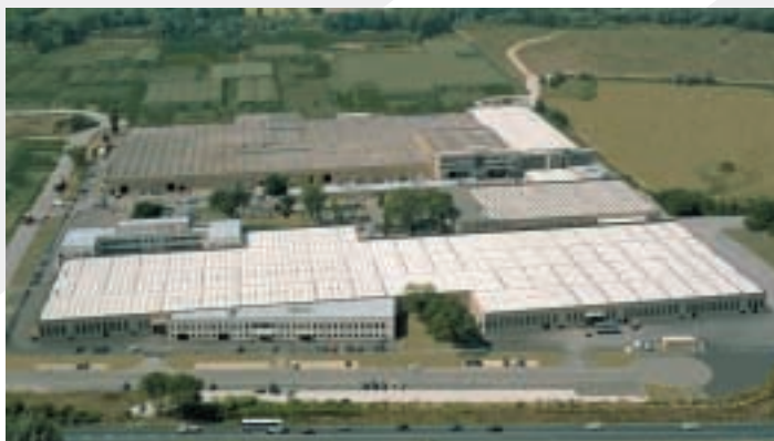
> Veduta aerea dello stabilimento Biesse - Pesaro
